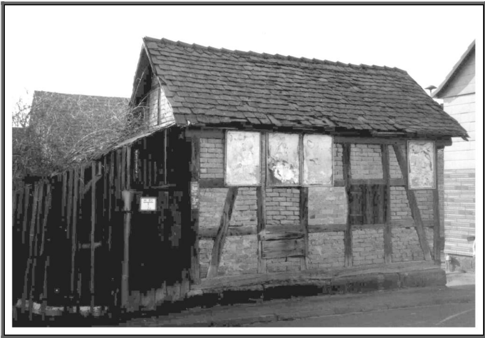
Feuerwehrgerätehaus von 1882, Auf der Pitze
