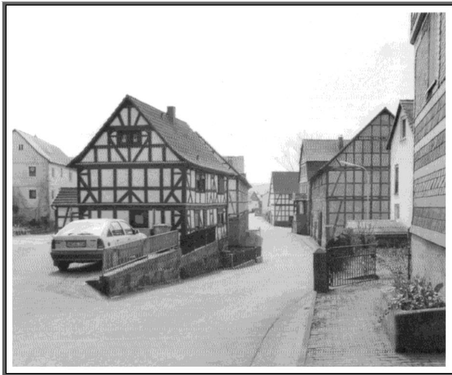
Kastanienstraße mit Blick nach Westen in den Wiesenhof
